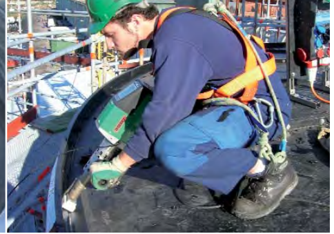
WELDPLAST EC4 asennuskäytössä.
