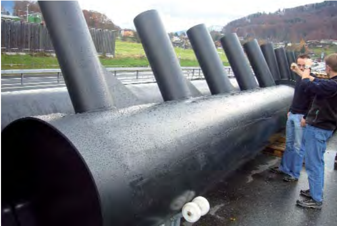
PE-putken valmistusta lämpöenergiajärjestelmiä varten Sveitsissä.
