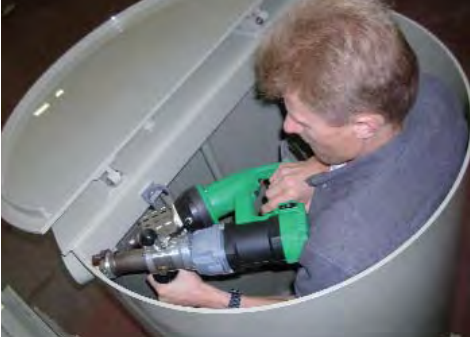
FUSION 2:n avulla työt voidaan tehdä ahtaissakin paikoissa.
