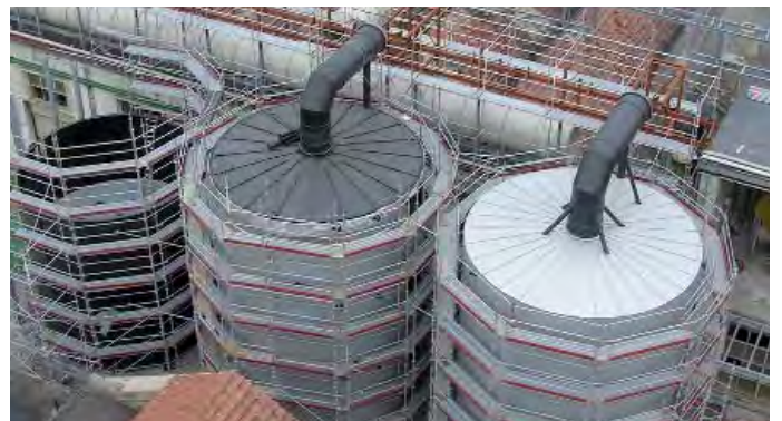
13 metriä korkeita HD-PE:stä valmistettuja siiloja Espanjassa.
